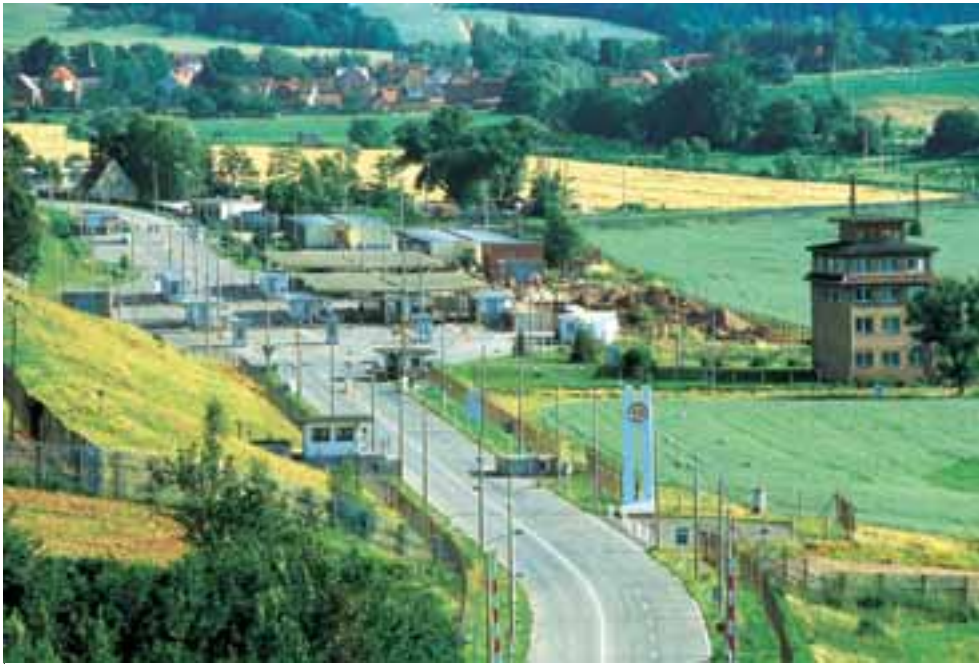
Grenzübergang Duderstadt-Worbis, mit Sicherheits- und Abfertigungsanlagen, DDR, um 1985. Blick vom Westen.
