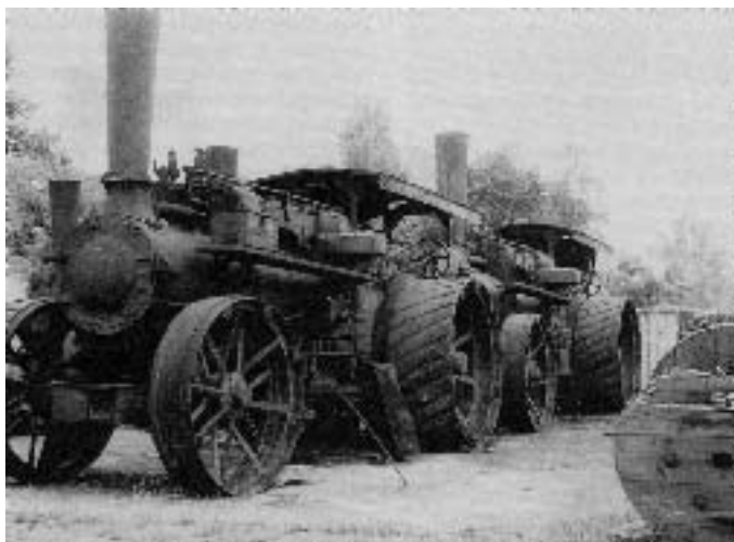
Dampfseilflug-Lokomotive zur Bearbeitung von Äckern
