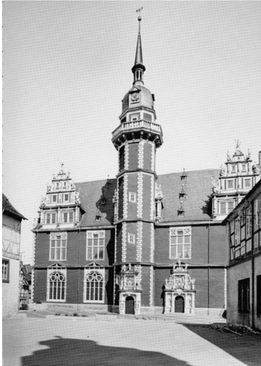
Das Juleum, Aula- und Bibliotheksgebäude der Universität Helmstedt, erbaut 1592-1597. Die 1576 eröffnete erste Hochschule in Niedersachsen wurde 1809 aufgehoben.
