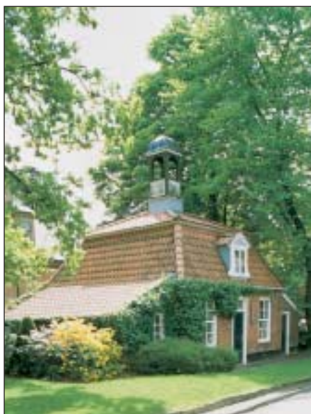
Pingelhus, ehemaliges Hafenwärterhaus Foto: Verkehrsverein Aurich
